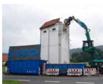
Abbruch des Transformators an der Hüttenstraße (19.08.2013)
