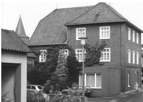
Das Gebäude der ehemaligen Fleischerei Konersmann an der Jahnstraße befindet sich nun im Besitz der Gemeinde.
