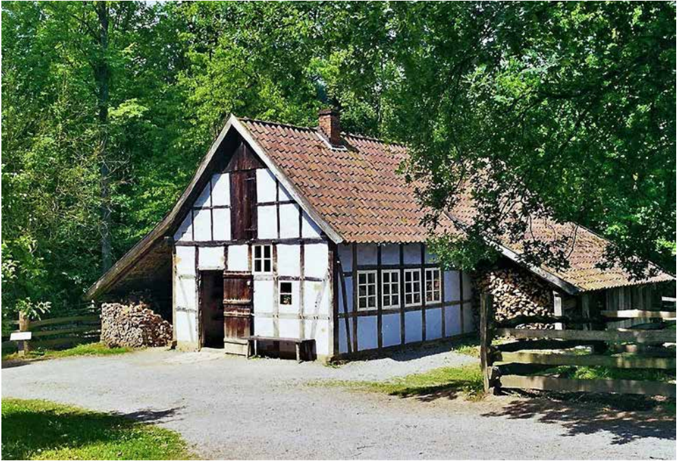
Abb. 10: Die im Jahre 1828 errichtete Töpferwerkstatt Hehemann wurde im Jahre 1982 im Freilichtmuseum Detmold wiederaufgebaut. Seit fast 40 Jahren ist das Gebäude wieder als Töpferei in Betrieb.
